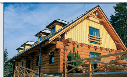
Dřevostavba penzionu Lada, Repechy
