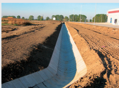
Logistický areál Lozorno – Matějkův kanál
