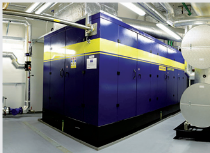
VYTEZA Vyškov (kogenerační jednotka)
